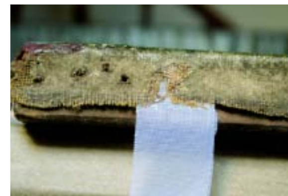
7. Applicazione delle fascette per il tensionamento ed il ripristino della chiodatura.
